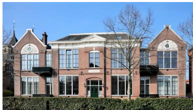
Deventer: voormalige Houtmarktschool
